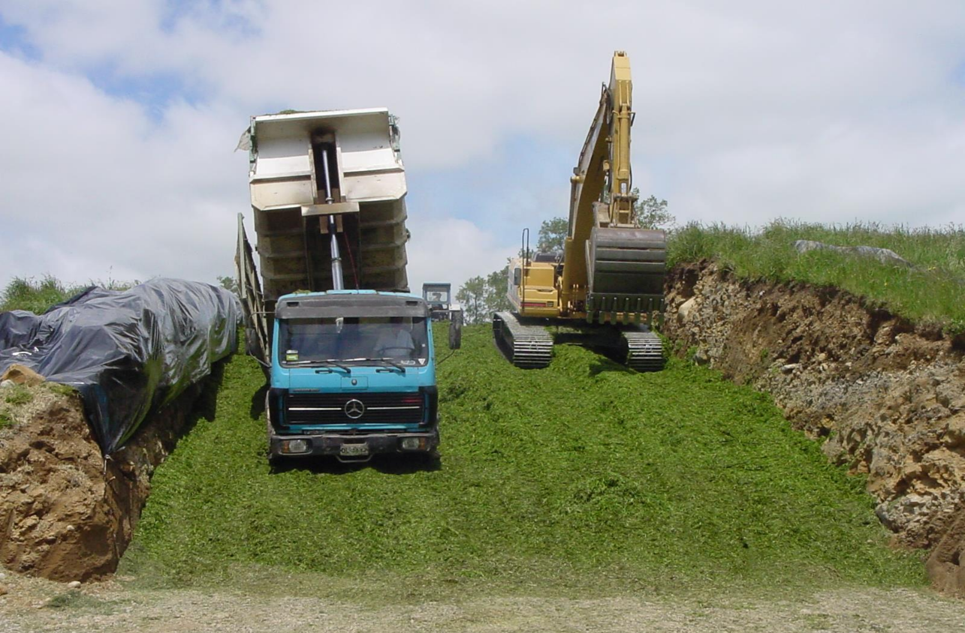
Llenado y Compactación del ensilaje
