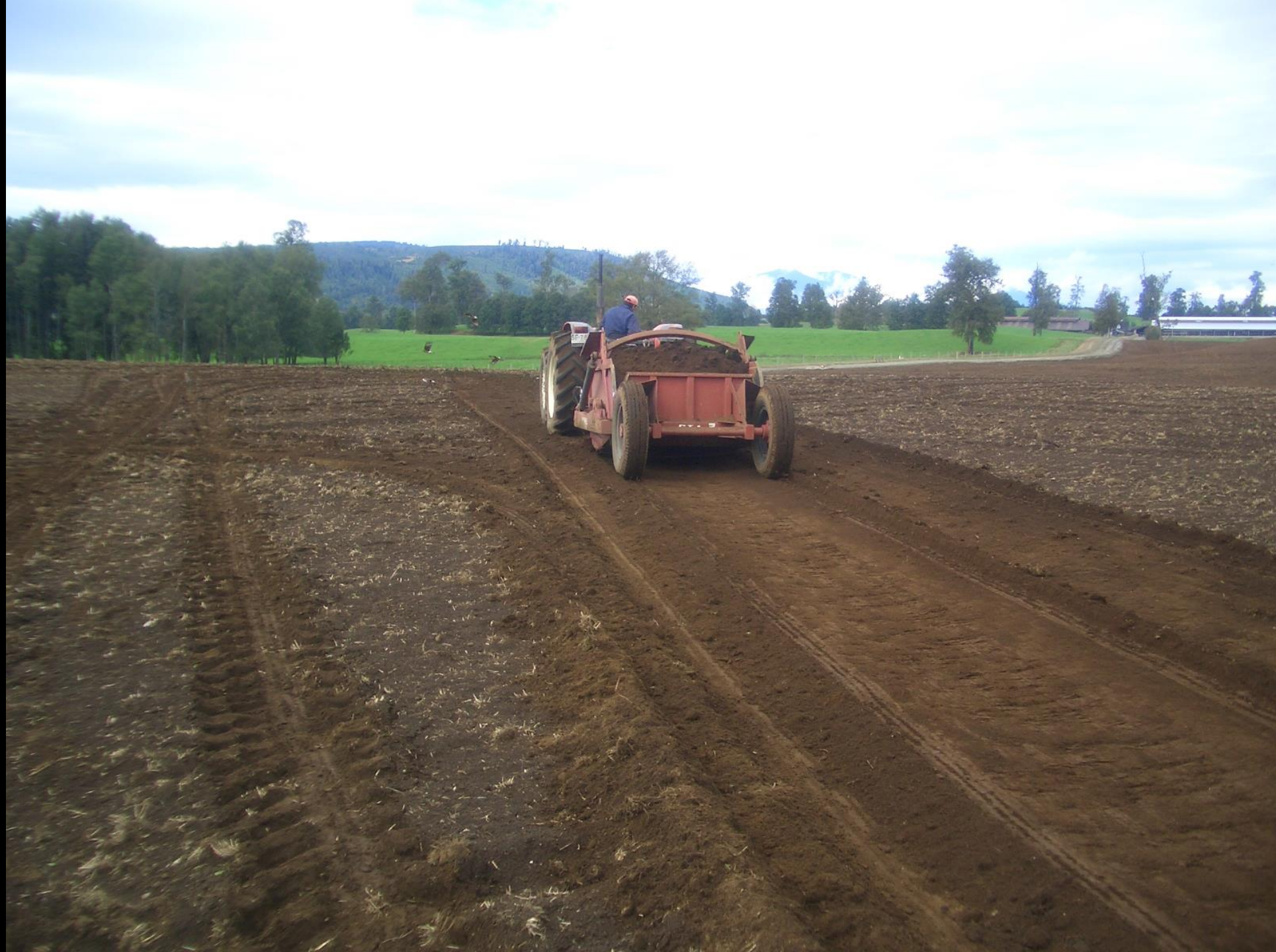
Construcción de badenes
